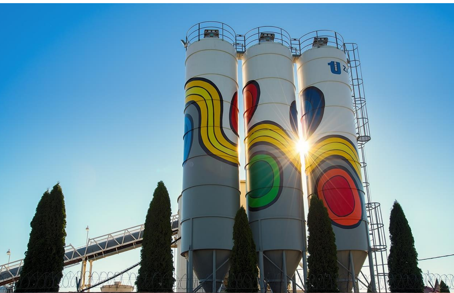
Impianto di produzione di calcestruzzo, Hlohovec, Slovacchia
